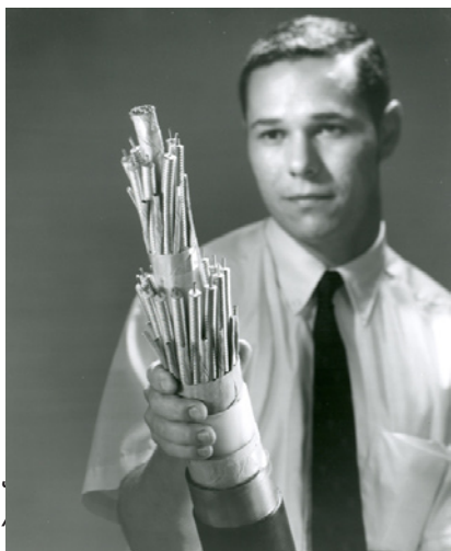
Az a 22 "csőből" álló koax kábel egyszerre 90.000 telefonbeszélgetést tudott továbbítani (1970)
